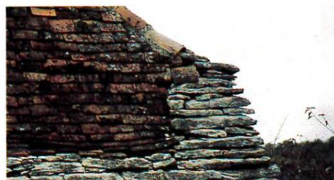
La nature du matériau utilisé détermine l'inclinaison de la pente : tuiles plates, lauzes calcaires ou de schistes, ardoises sur les toitures à forte pente, tuiles canal sur les toitures à faible pente, tuiles mécaniques sur les toitures à pente intermédiaire.
